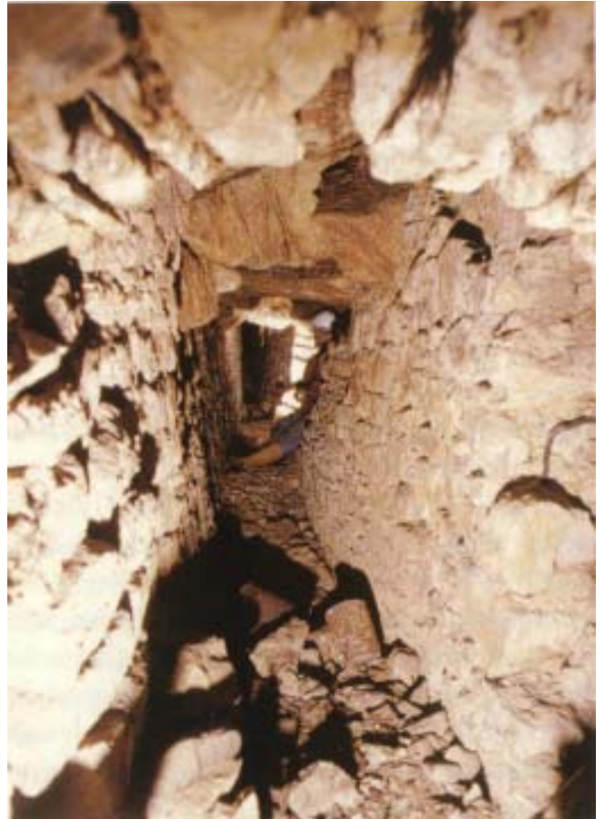
Abb.: Tiergartentunnel von Blankenheim. Blick in den Tunnel kurz nach der Wiederöffnung während der archäologischen Untersuchung 1999.
