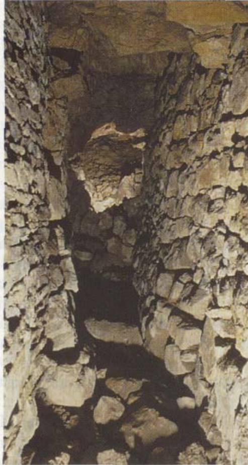
Bild 4: Blick in den Tunnel der Wasserversorgung zur Burg Blankenheim
