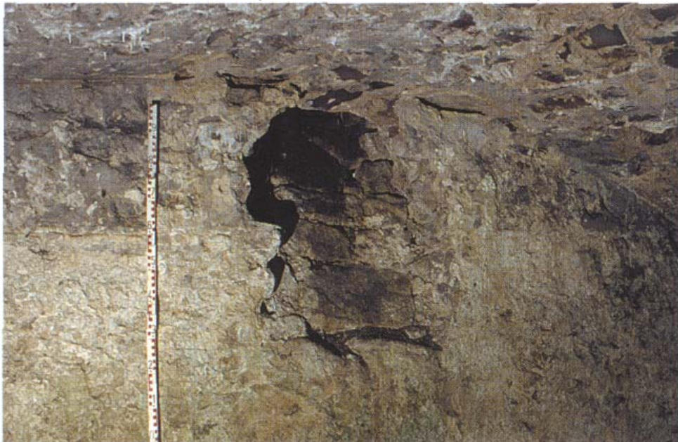
Bild 1: Die Kalkablagerungen an den Wänden belegten die Funktion dieses Bauwerks als Wasserhäuschen: Es handelte sich um den Zwischenspeicher der Wasserversorgung von Burg Blankenheim
