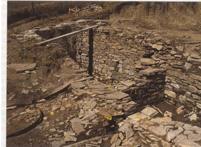
Bild 7. Die Brunnenstube »Alte Quelle« am Kopf der Wasserleitung
